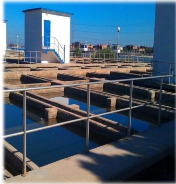
**Figure 3 : Décanteurs**
