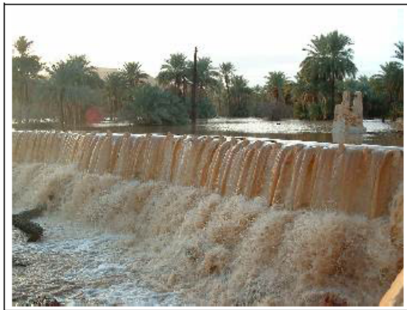
Figure 4.2 : Crues (Beni Isguen) et digue (Bouchen)
