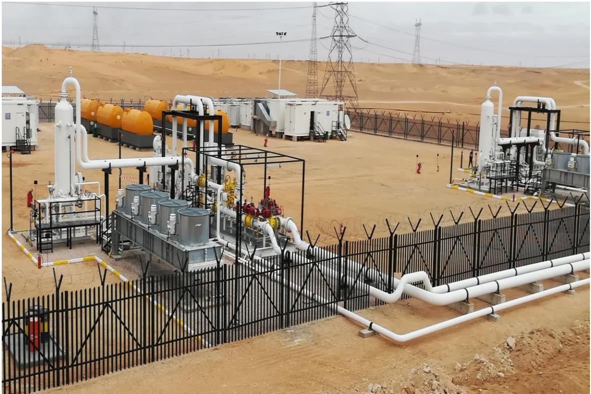
**Figure II.8 :** Pompes multiphasiques type III
