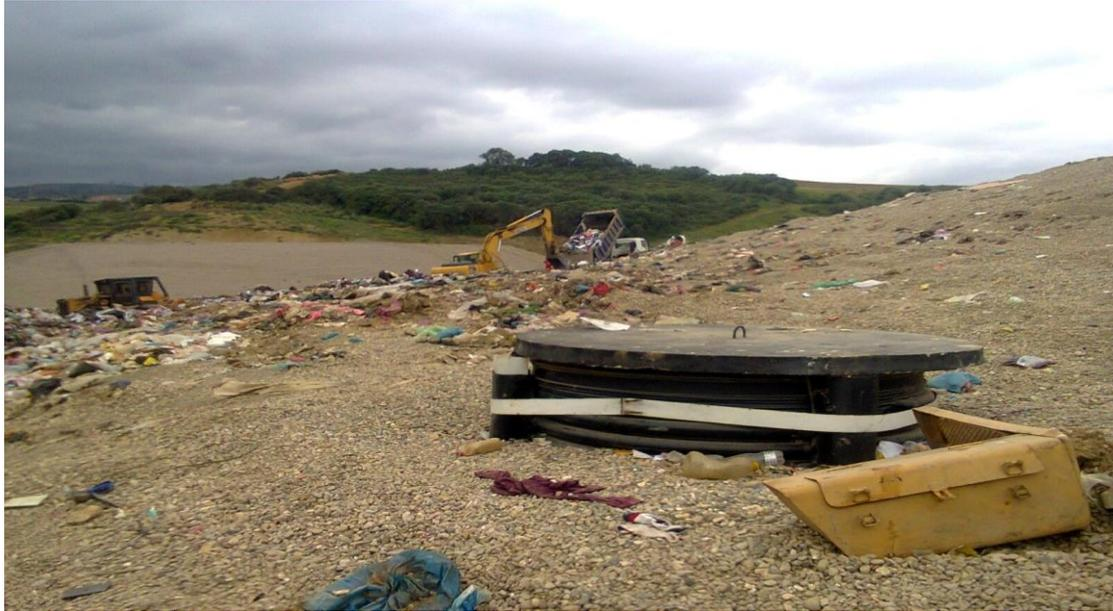
**Figure 1.5** : Pui de captage du biogaz.
