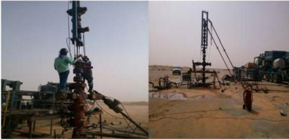
Montage de l'installation sur la tête de puits Avant l'opération de Fracturation
