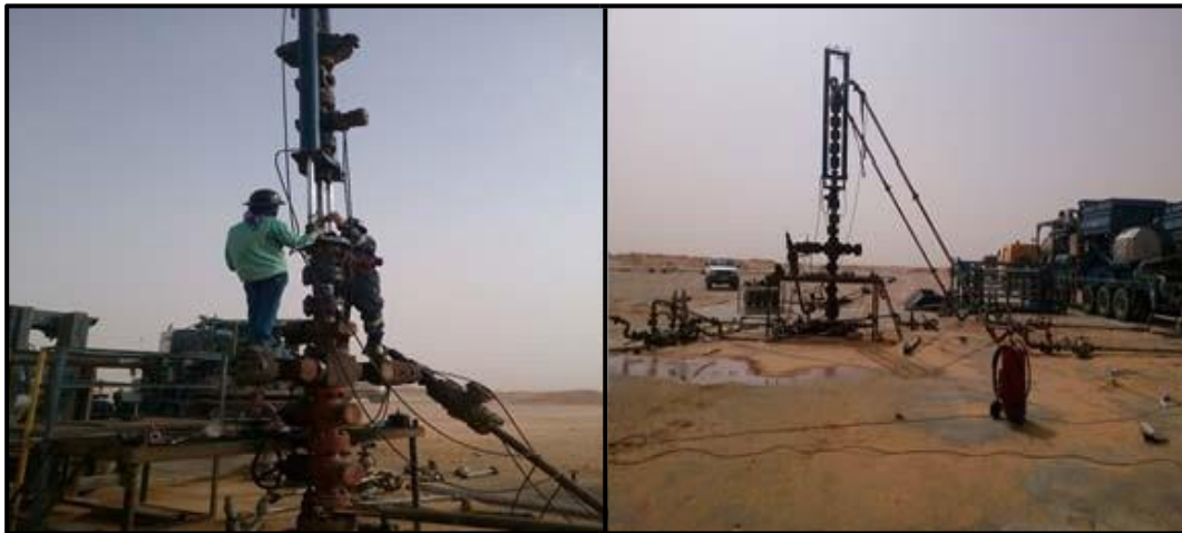
Figure IV.28 : Montage du "Tree Saver"
