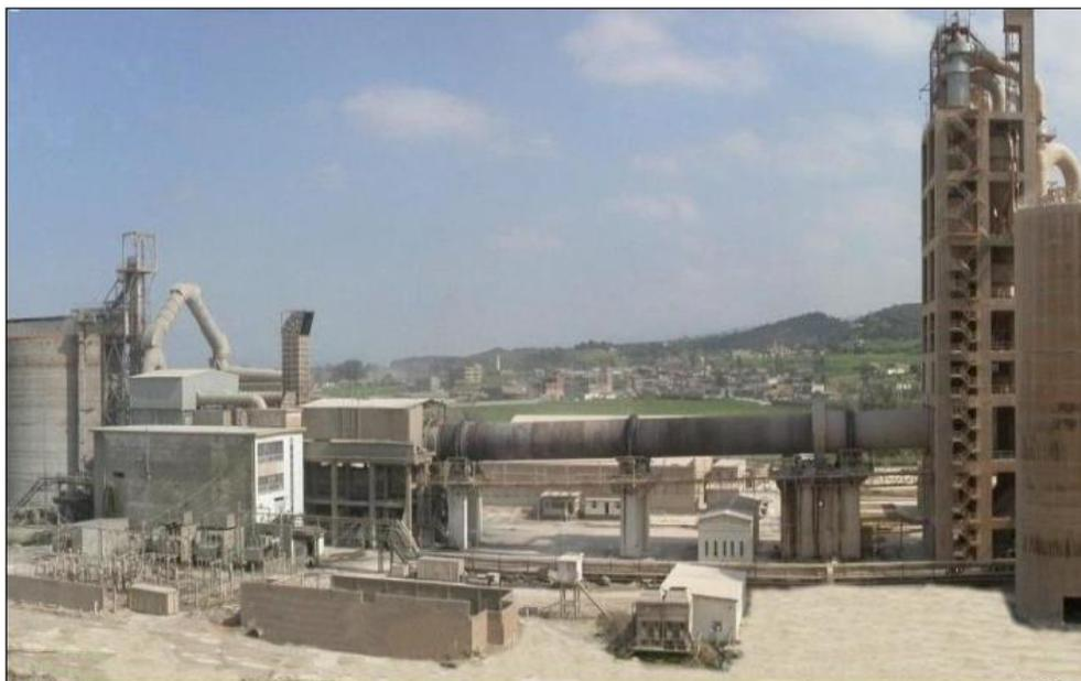
**Figure 20** : Cuisson de clinker dans le four horizontal (GICA SCMI, 2010)
