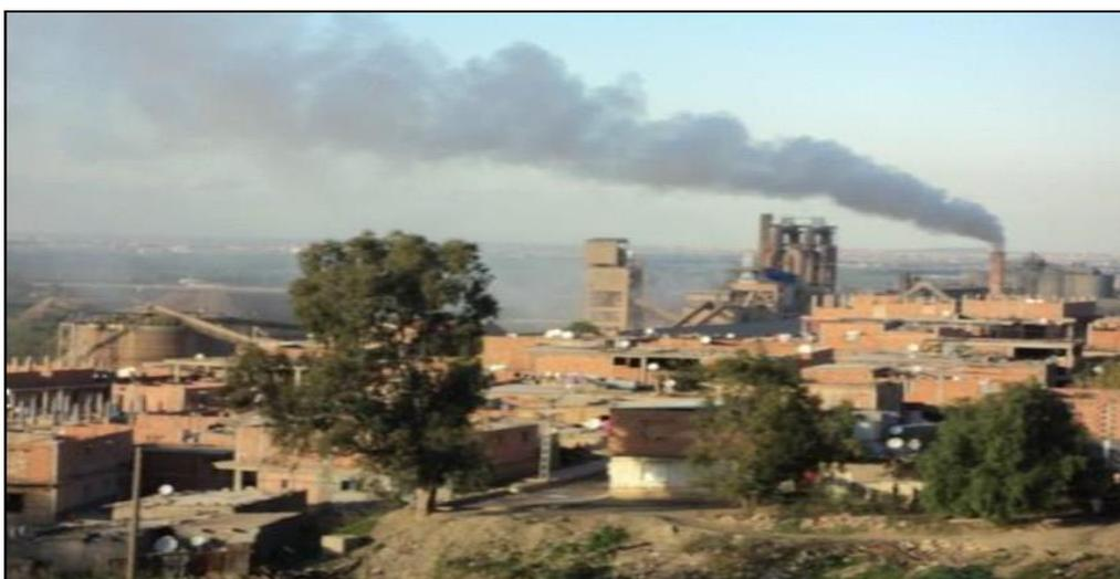
**Figure 42 :** Panache de poussières visibles émis par la cheminée du four de l'usine de Meftah.
