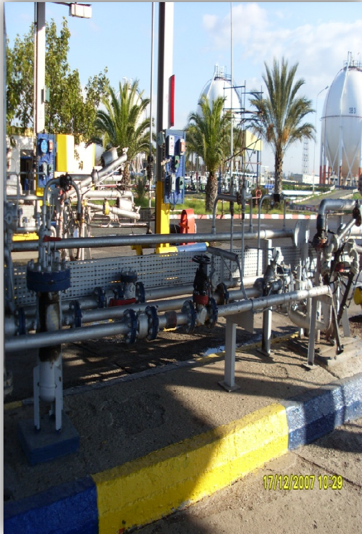
Figure06 : bras et ilots de chargement
