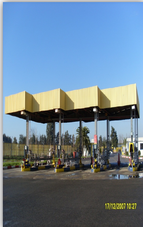
Figure06 : bras et ilots de chargement
