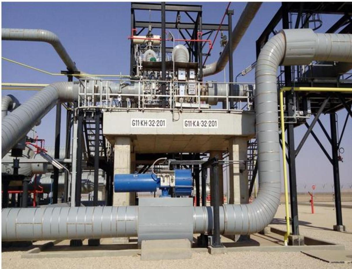
**Fig.II.1** : Turbo-Expander à paliers magnétiques au CPF GT.
