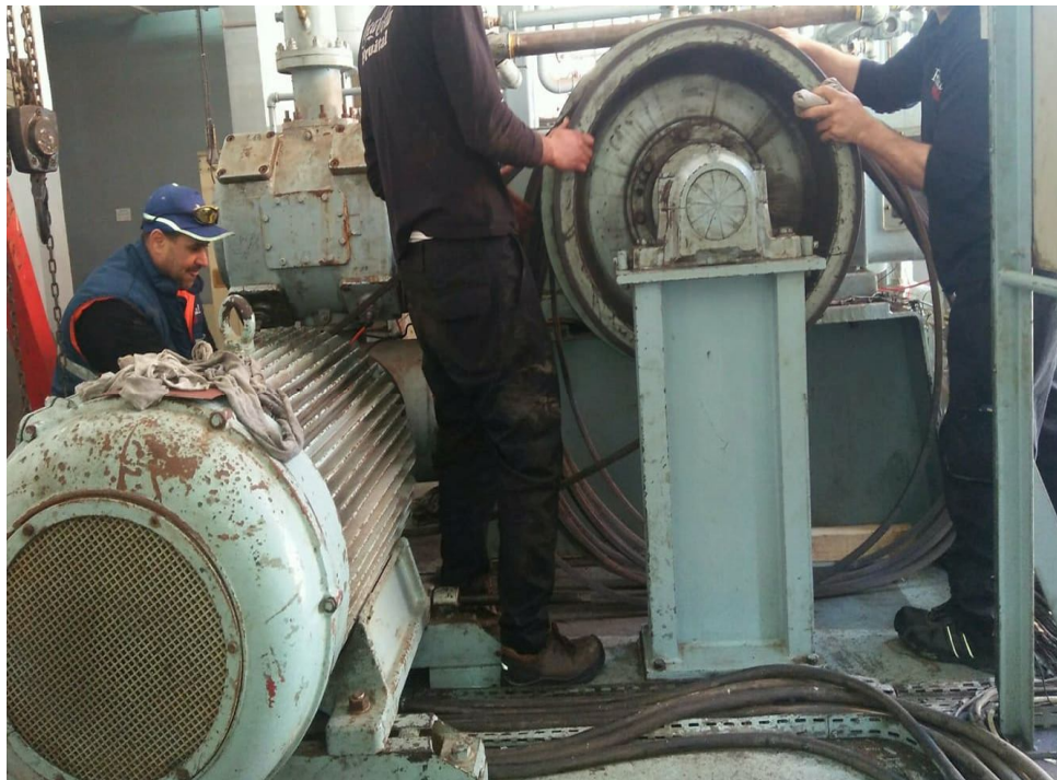
Fig. III.16. Fixation moteur électrique- alignement des courroies
