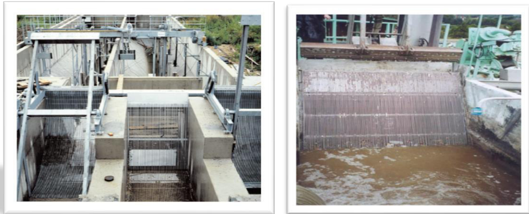
Figure II.2 : Dégrilleur à la sortie du barrage.
