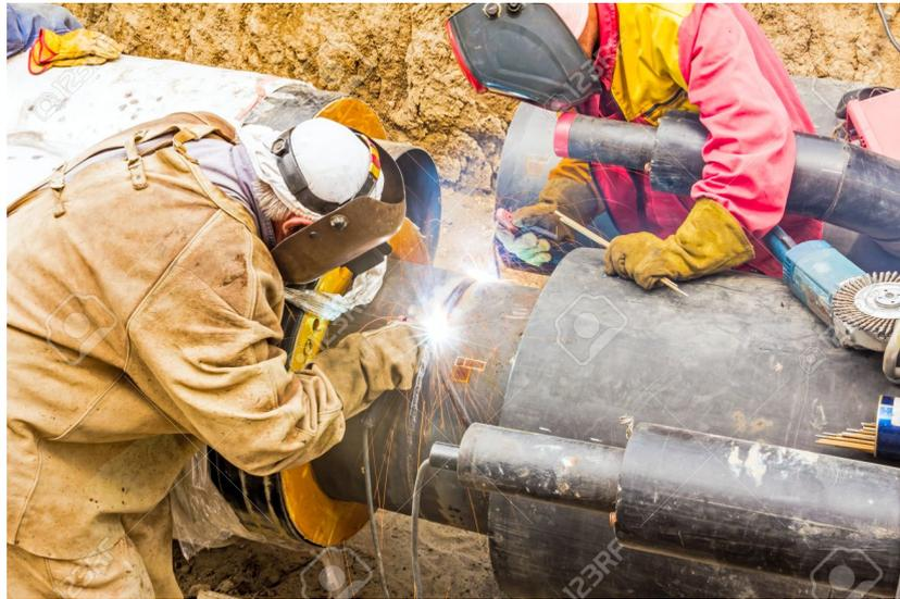
**Figure I.3 : Soudage sur sites des pipes.**
