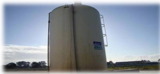
**Figure N°.III.9 :** Cuve de stockage du FeCl<sub>3</sub>.
