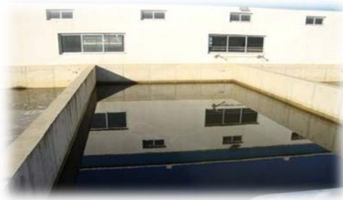
Figure N°.III.11 : Filtre plein pendant le fonctionnement.
