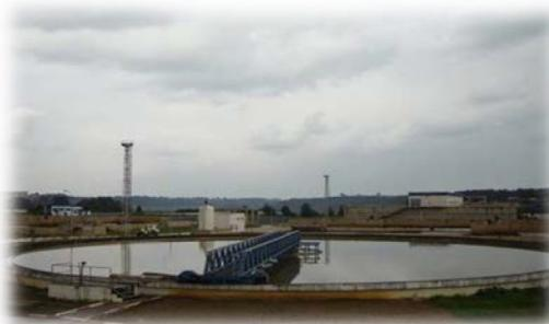
Figure N°.III.7 : Décanteur primaire.
