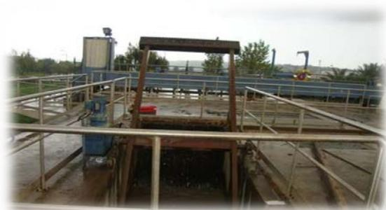
**Figure N°.III.4 :** Dégrilleur automatique.
