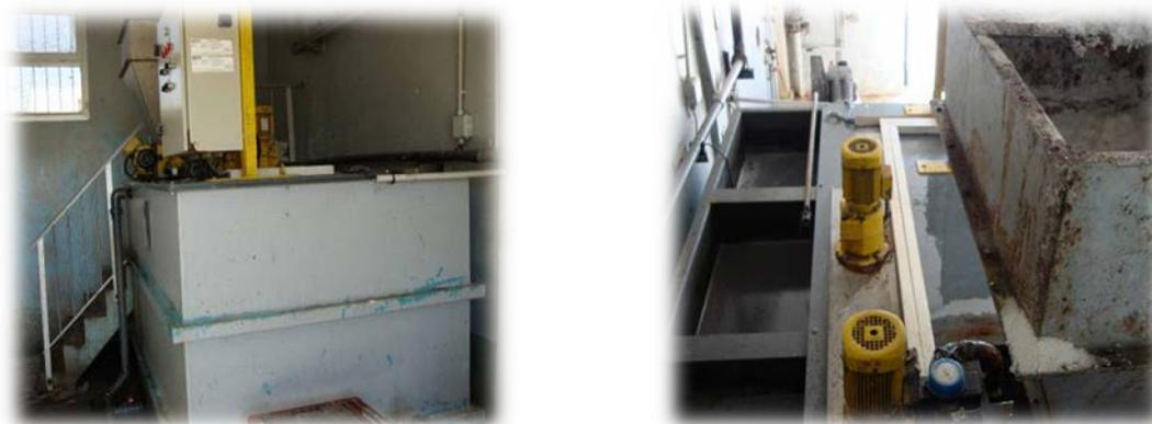
**Figure N°III. 17 :** Bac de préparation du polymère.
