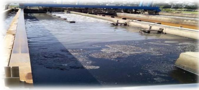
Figure N°.III.6 : Désableur/Dégraisseur.
