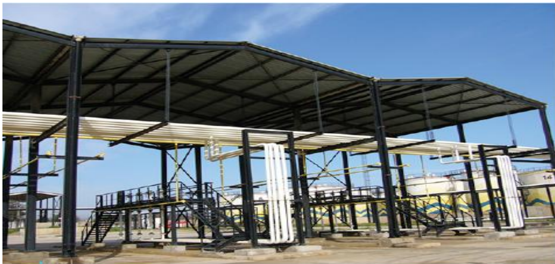
Fig. I.4 : Parc de stockage carburant et pipe rack (document interne)
