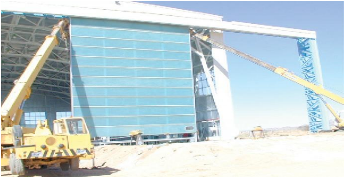
Fig. I.8 : Montage porte hangar avions (document interne)
