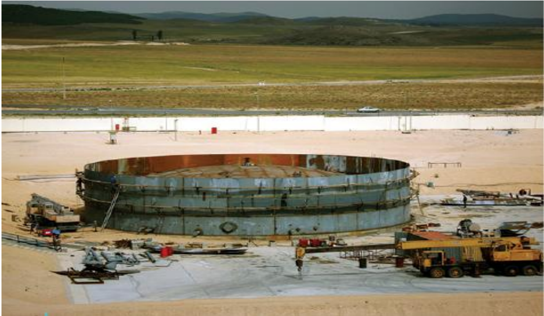
Fig. I.10 : Montage bac a toit flottant (document interne)
