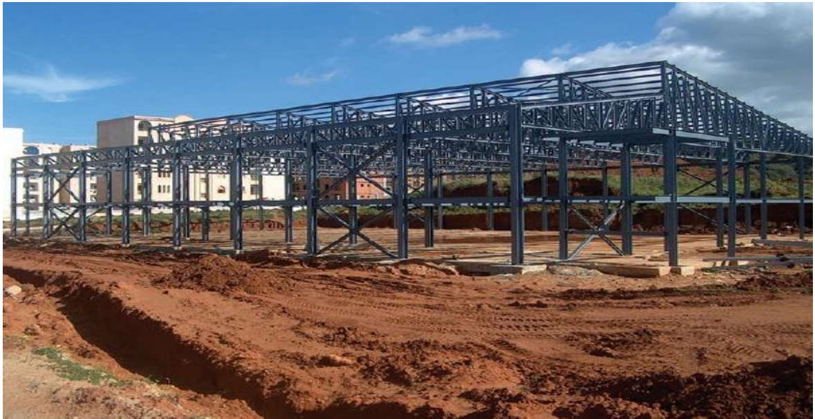
Fig. I.7 : Réalisation hangar de maintenance (document interne)
