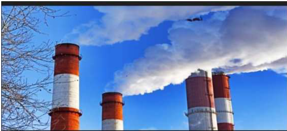
Figure I.1 : rejet gazeux de centrale de cap djinet
