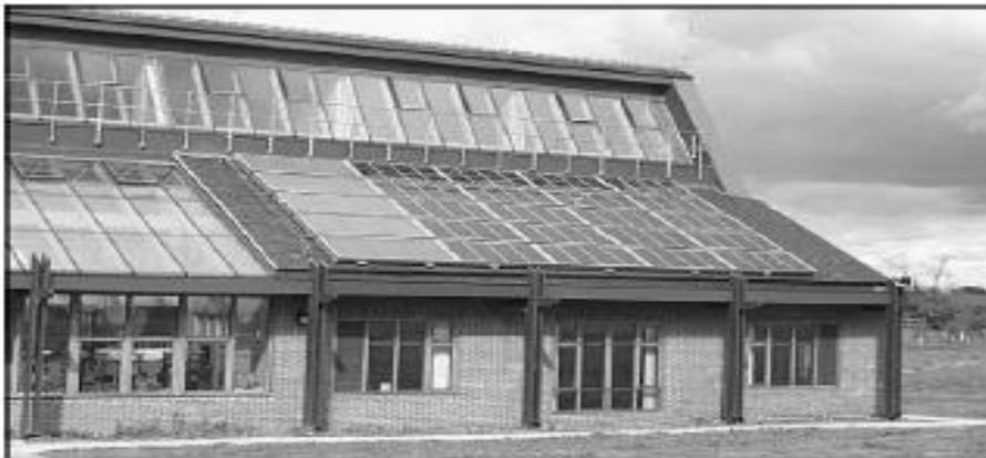
**Figure II.4:** Capteurs solaires combinés intégrés à la toiture du Brockshill Environment Center.
