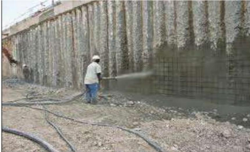
Figure III-3 : Soutènement par pieux espacés
