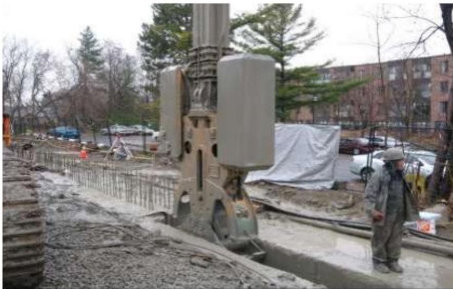
Figure III-1 : Soutènement par paroi moulée.
