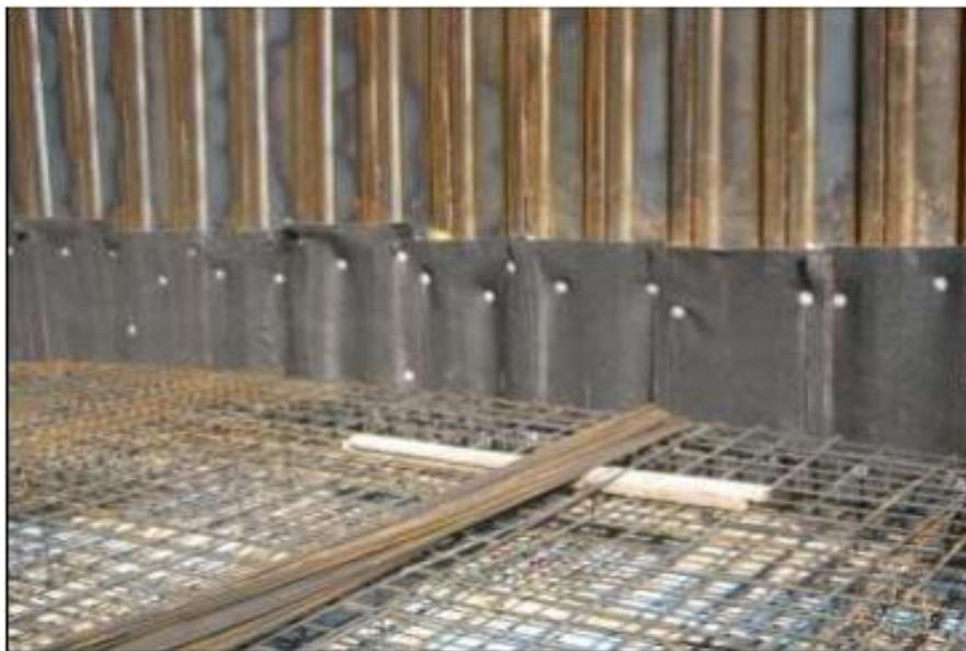
Figure III-2 : Soutènement par rideaux de palplanches.
