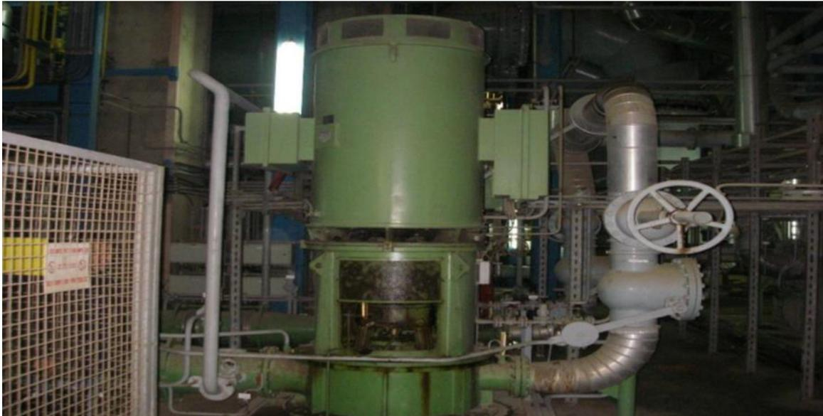
Figure I. 3: Pompe d'extraction
