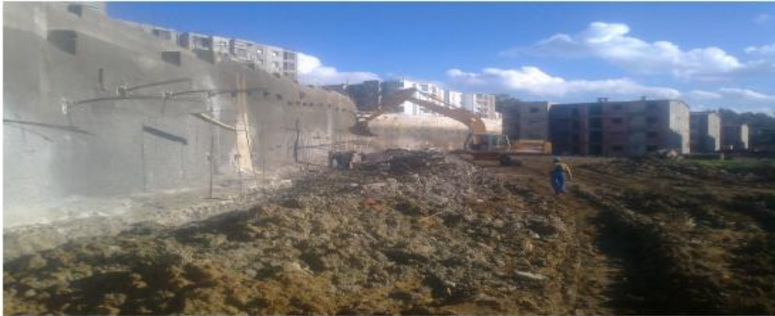
III- Figures 16 : Mur à paroi tirantée (Boumerdes ,2012).
