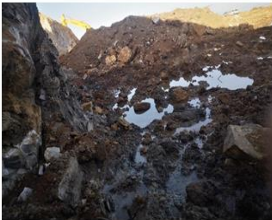
IV- Figure 5: montrant des venues des eaux vers la plateforme.
