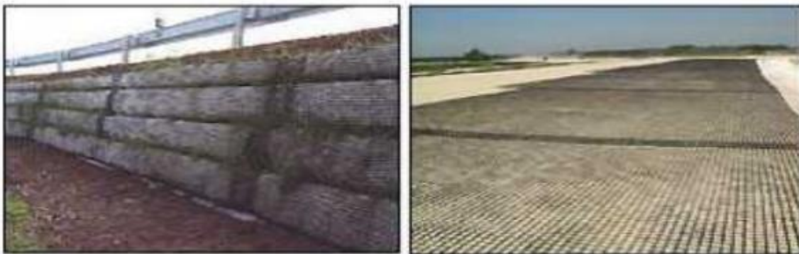
III- Figure 12 : Renforcement par géo synthétique.
