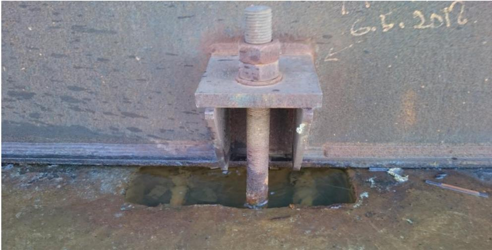
Figure V. 2: Tige d'ancrage.
