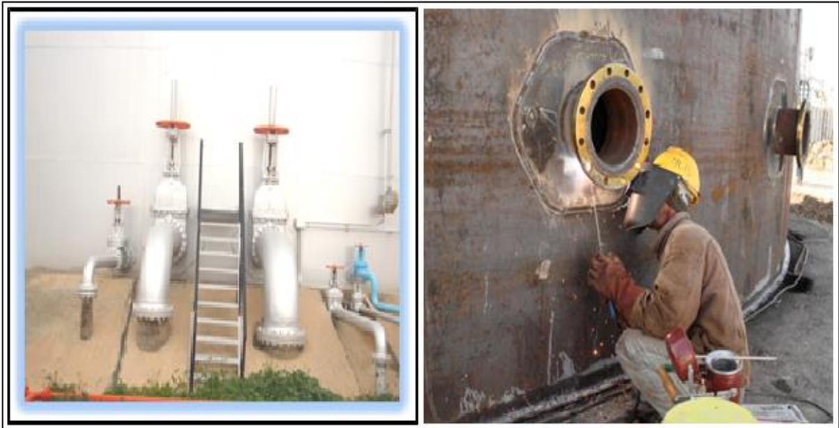
Figure VII. 2: Tubulures.
