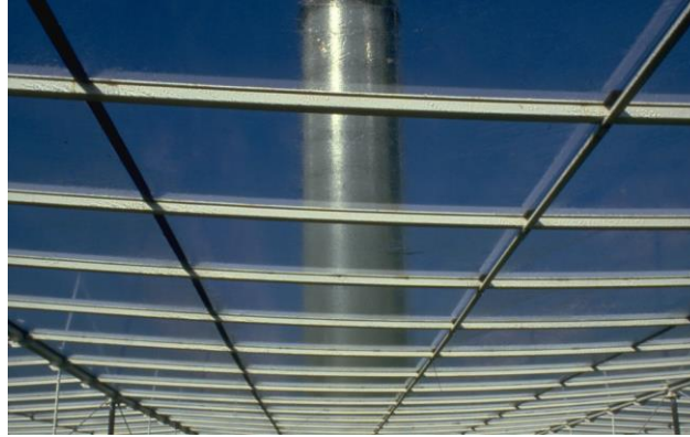
Figure I.3. Collecteur de la centrale a cheminée solaire de Manzanares.
