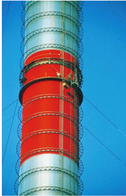
Figure I.6. Cheminée de la centrale a cheminée solaire de Manzanares
