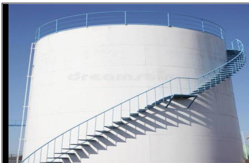
Figure V. 10: Montage d'escalier hélicoïdal d'un réservoir cylindrique.
