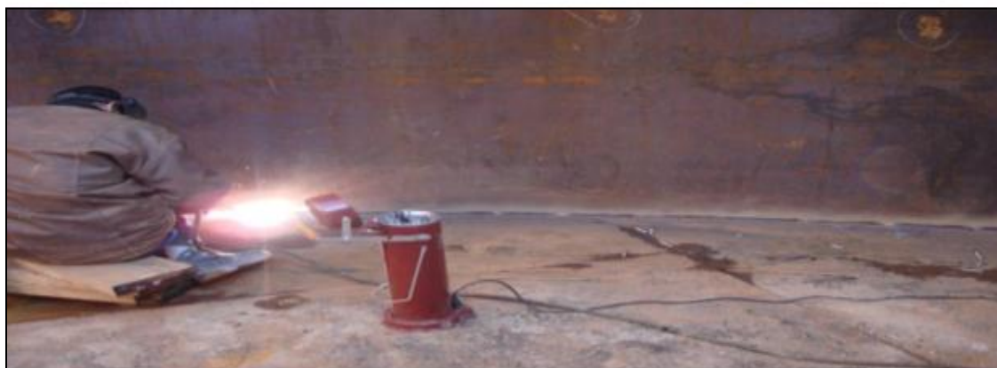
Figure VII. 10: soudage de 1 ère virole sur le fond.
