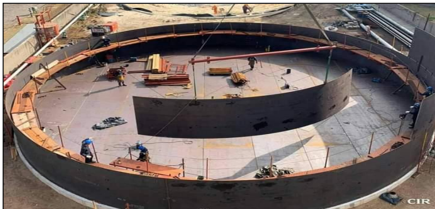
Figure VII. 8: Mise en plan de soudage des viroles.
