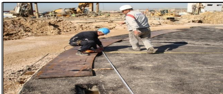
Figure VII. 5: Repérages des tôles marginales.
