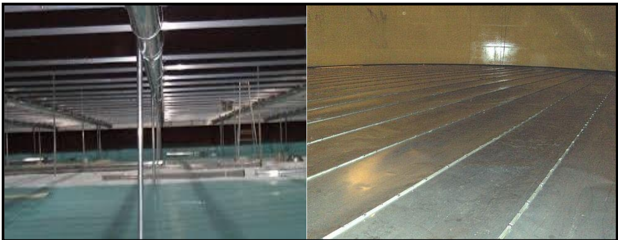
Figure VI. 4: Ecran flottant de toit fixe
