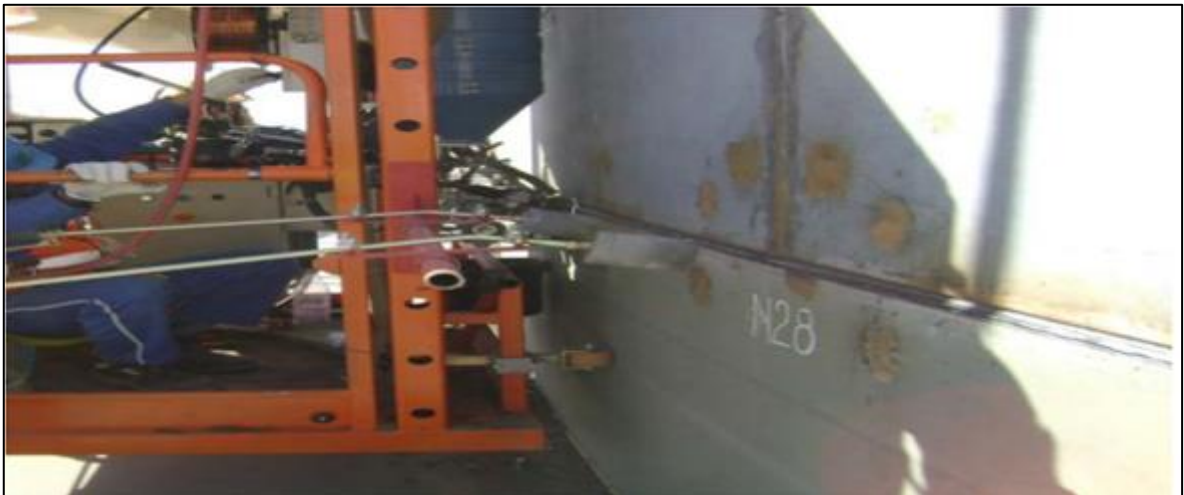
Figure VI.12 Soudage des cordons horizontaux entre deux viroles
