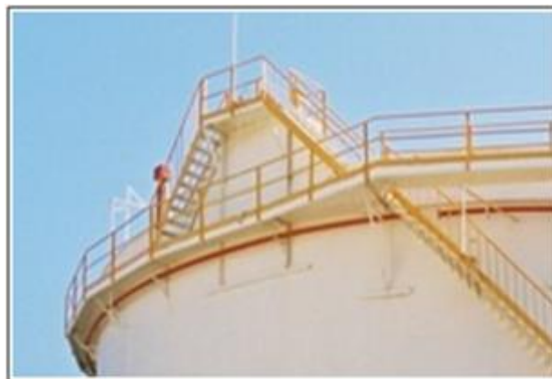
Figure IV. 11 Plateforme et passerelle
