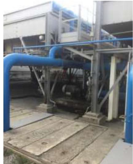
**Figure A.1.14:** Système des aéroréfrigérants.
