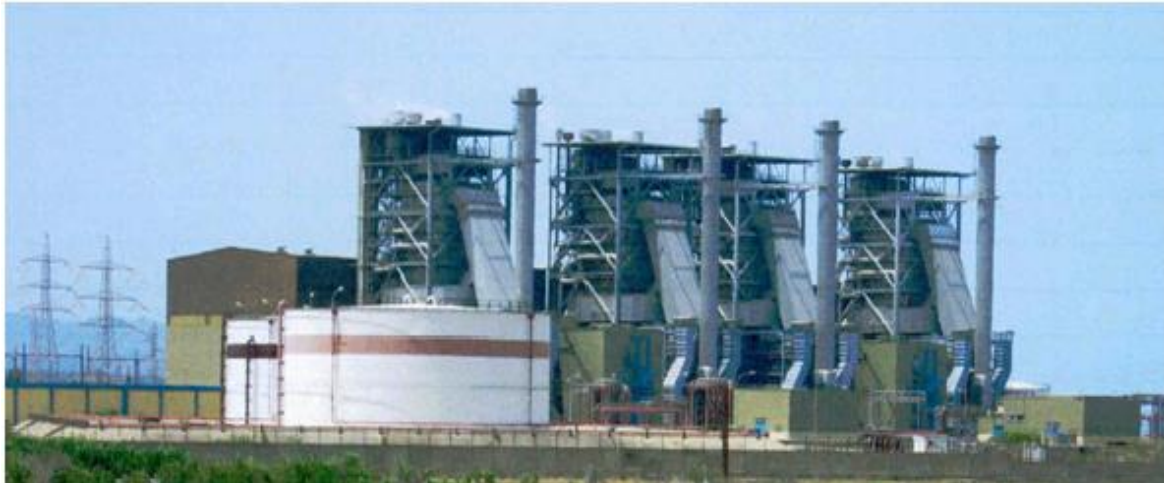
Figure I.1. La centrale thermique de CAP-DJINET.
