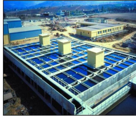
**Figure N°6 : Décanteurs**
