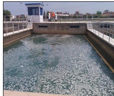
**Figure N°8 : Filtre à sable pendant la filtration**
