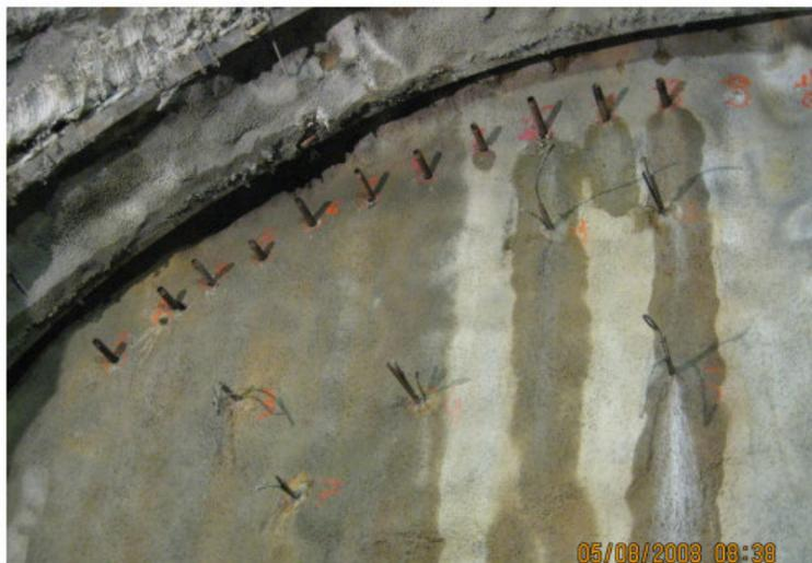
Fig. III.2 Ensemble de tubes de la voûte parapluie
