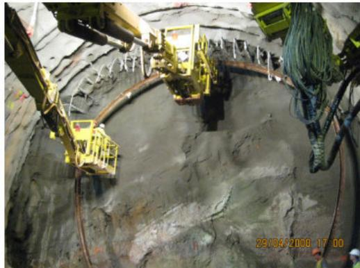
Fig. III.4 Pose et réglage des cintres
