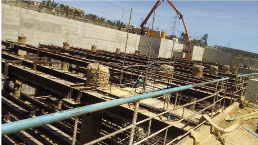
Fig. III.14. Parois d'une station en cour de la réalisation
