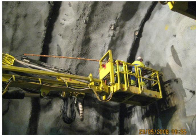
Fig. III.3 Enfilage d'un boulon en fibre de verre
