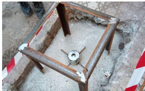
Fig. III.7. Mise en place d'un repère de mesure de tassement en surface
