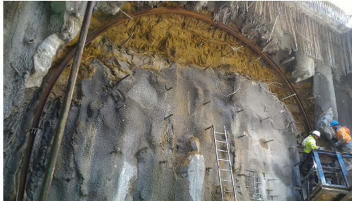
Fig. III.19. Mise en place des renforcements et des cintres métalliques.
