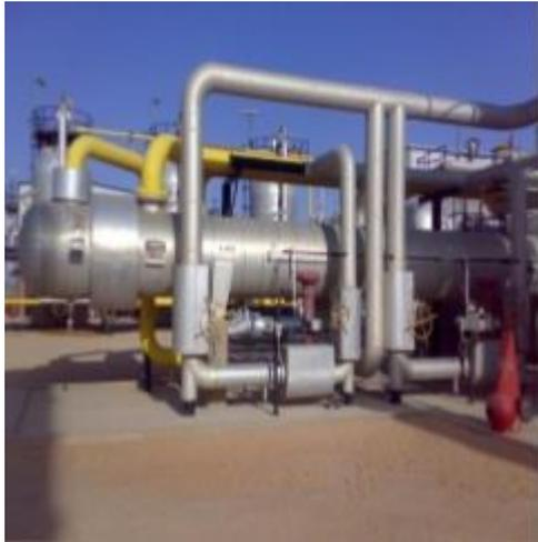
**Figure III.4 :** Echangeur gaz-gaz E403A/B
