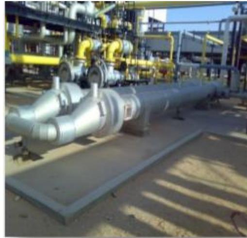
**Figure III.5 :** Echangeur gaz-liquide
