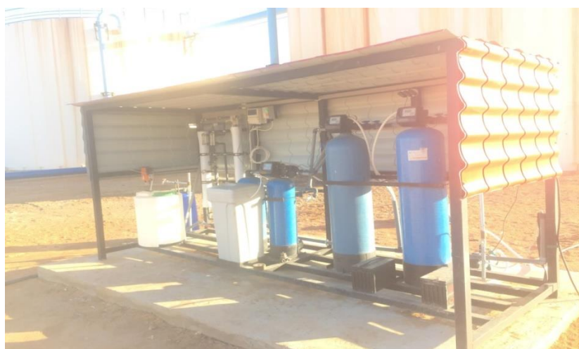
Figure III- 2 : Unité pilote de traitement d'eau
