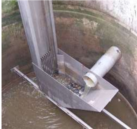
Figure 2.2 : Illustration d'un Dégrilleur automatique vertical amont aval [4].
