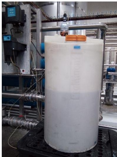
**Figure 1.11 :** Cuve de Dosage du séquestrant
