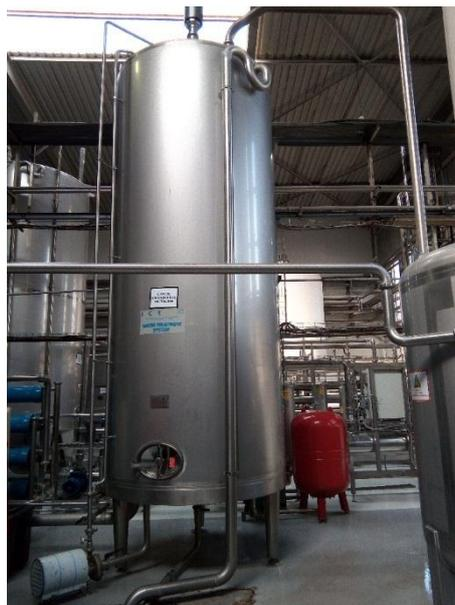
**Figure 1.10 :** Réservoir de stockage de l'eau prétraitée
