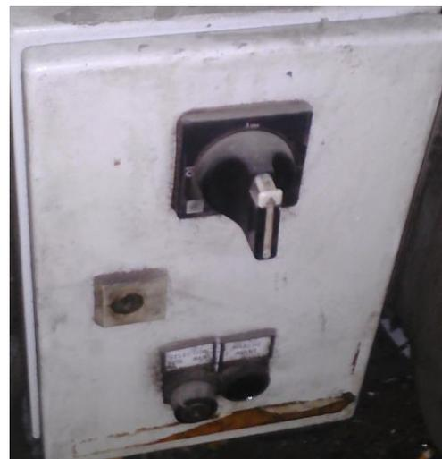
Figure 1.18. Coffret démarreur pour le tapis AVAL X-RAY
