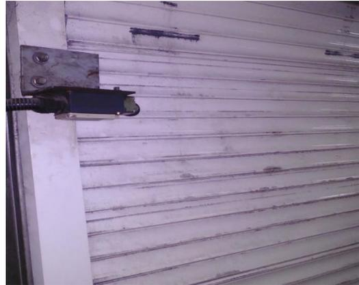
Figure 1.10. Volet anti-intrusion fermé et capteur fin de course mécanique haut
