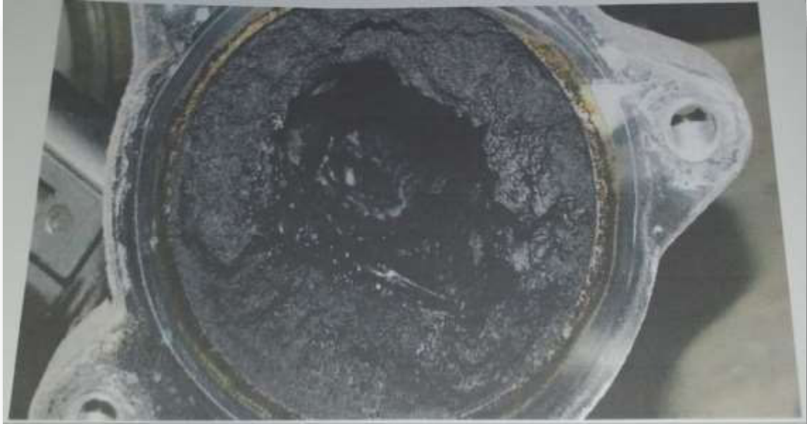
Figure 10: Déposition des paraffines dans les conduites.
