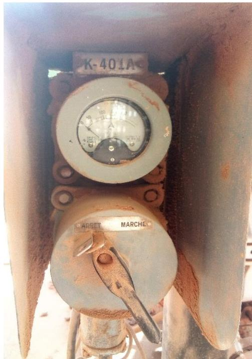
**Figure II. 6 :** L'interrupteur sectionneur (marche/arrêt de compresseur K-401).
