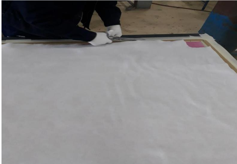
**Figure III.22 :** Dépôt de feutre de drainage
