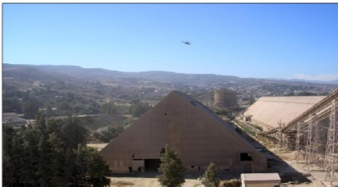
**Figure IV.5 :** Hall de pré homogénéisation. [6]
