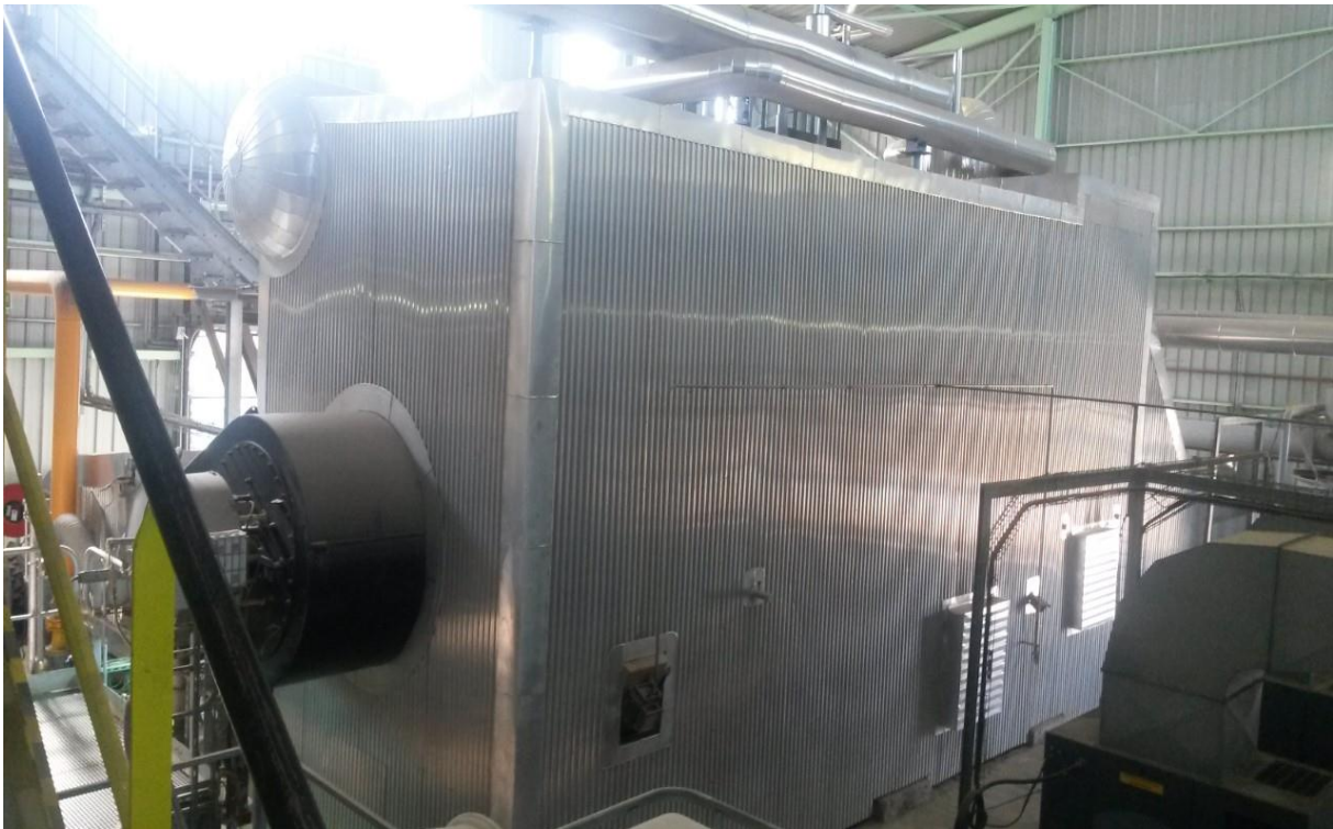
Figure 3.3 : Chaudière à tubes d'eau
