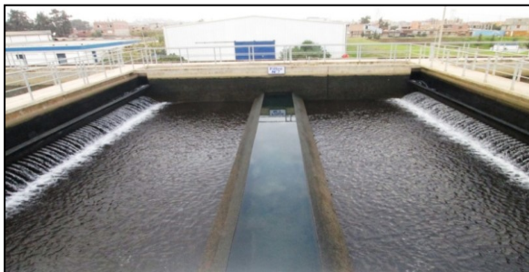
Figure N° 12: Filtre en remplissage et filtration.
