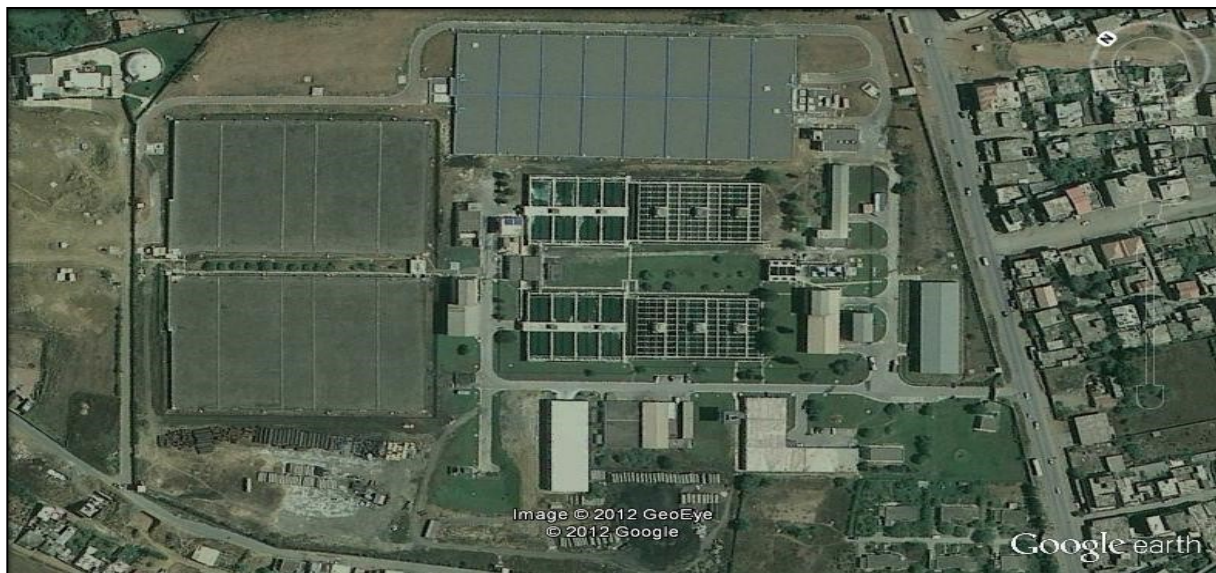
Figure N° 3: Vue générale aérien du SEAAL BOUDOUAOU
