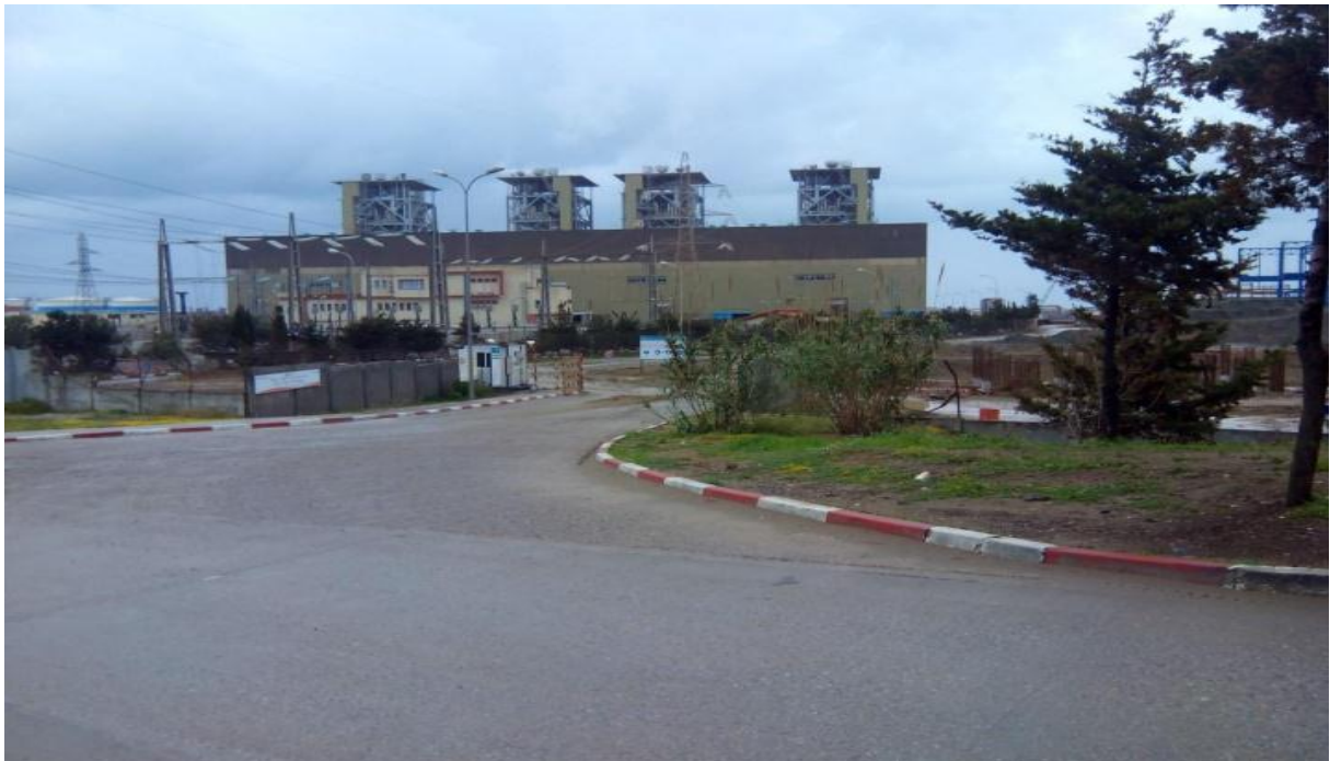
Figure I.1 : Photo réelle de la centrale thermique de Ras-Djinet.
