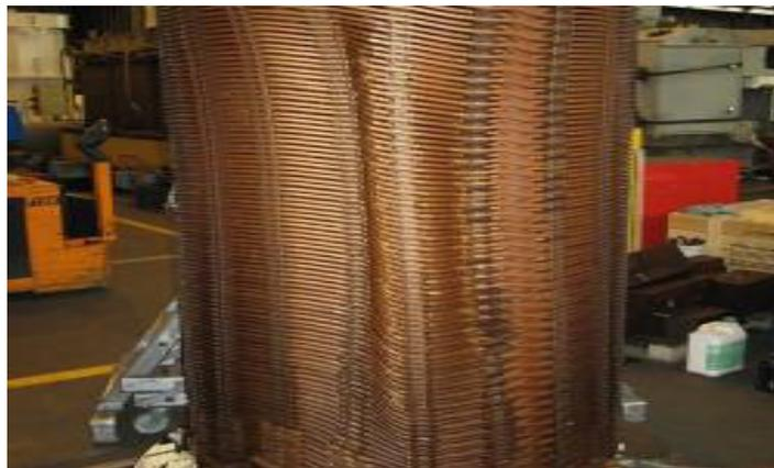
**Figure III.4 :** déformations mécanique de l'enroulement 30 KV d'un transformateur 40 MVA résultant d'efforts électrodynamiques.
