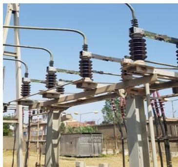
e) sectionneur d'isolement.
