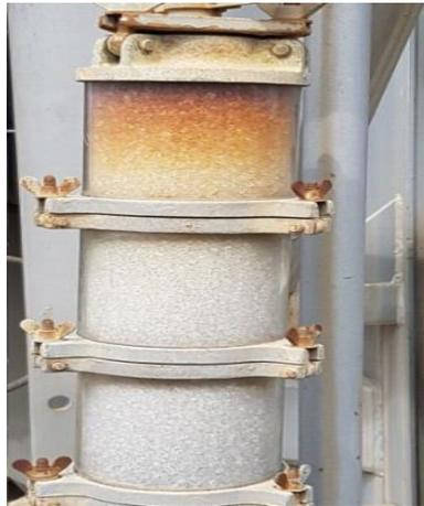
**Figure I.15** : L'assécheur d'air.
