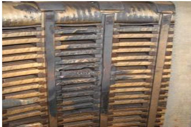
**Figure III.2:** Défaut de type diélectrique.
