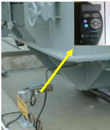
**Figure IV.6 :** Relais à maximum de courant (protection masse cuve).
