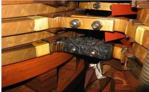
Figure III.7 : Point chaud sur connexion boulonnée.
