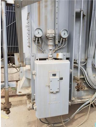
**Figure I.17 :** Coffret de commande du changeur de prise en charge.
