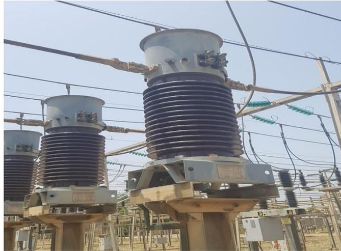
**Figure I.7:** Transformateur de courant.
