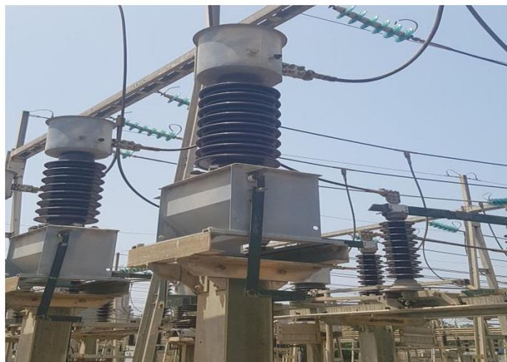
**Figure I.10 :** Transformateur de tension.
