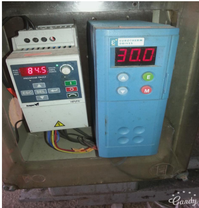
Fig IV.4. Réglage des fréquences de translation et de rotation
