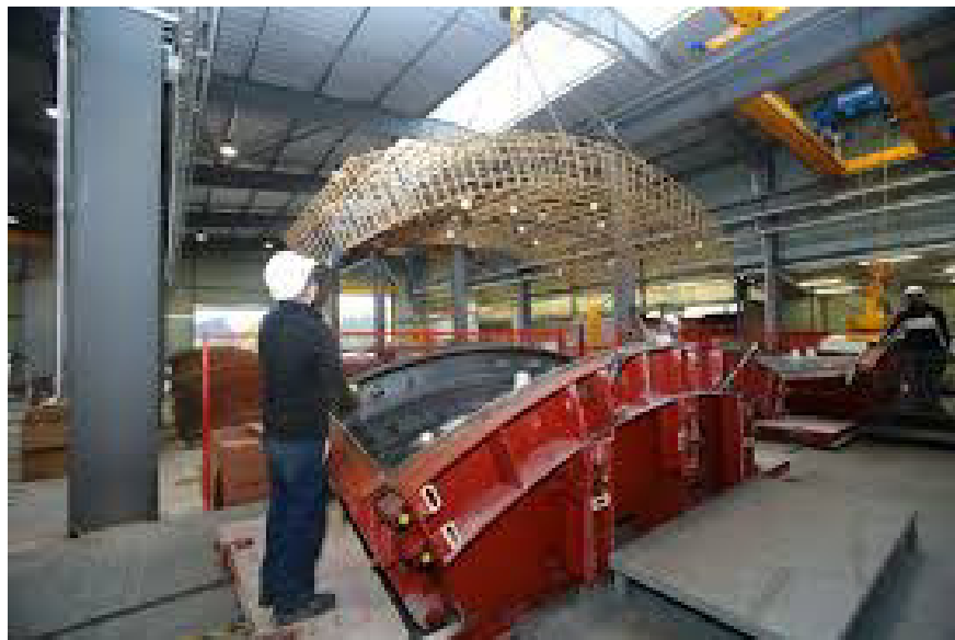
Figure II.4 : tunnels d'étuvage pour moules de voussoirs.
