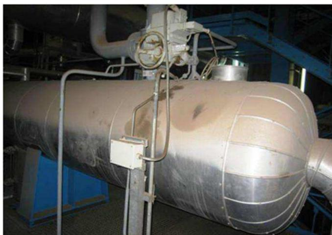
**Fig.1.9.** Vue de réchauffeur basse pression (BP).
