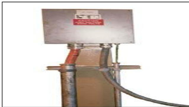
**Figure VI.4 : Junction Box****VI .3.1.4.Wellhead (tête de puits)**
