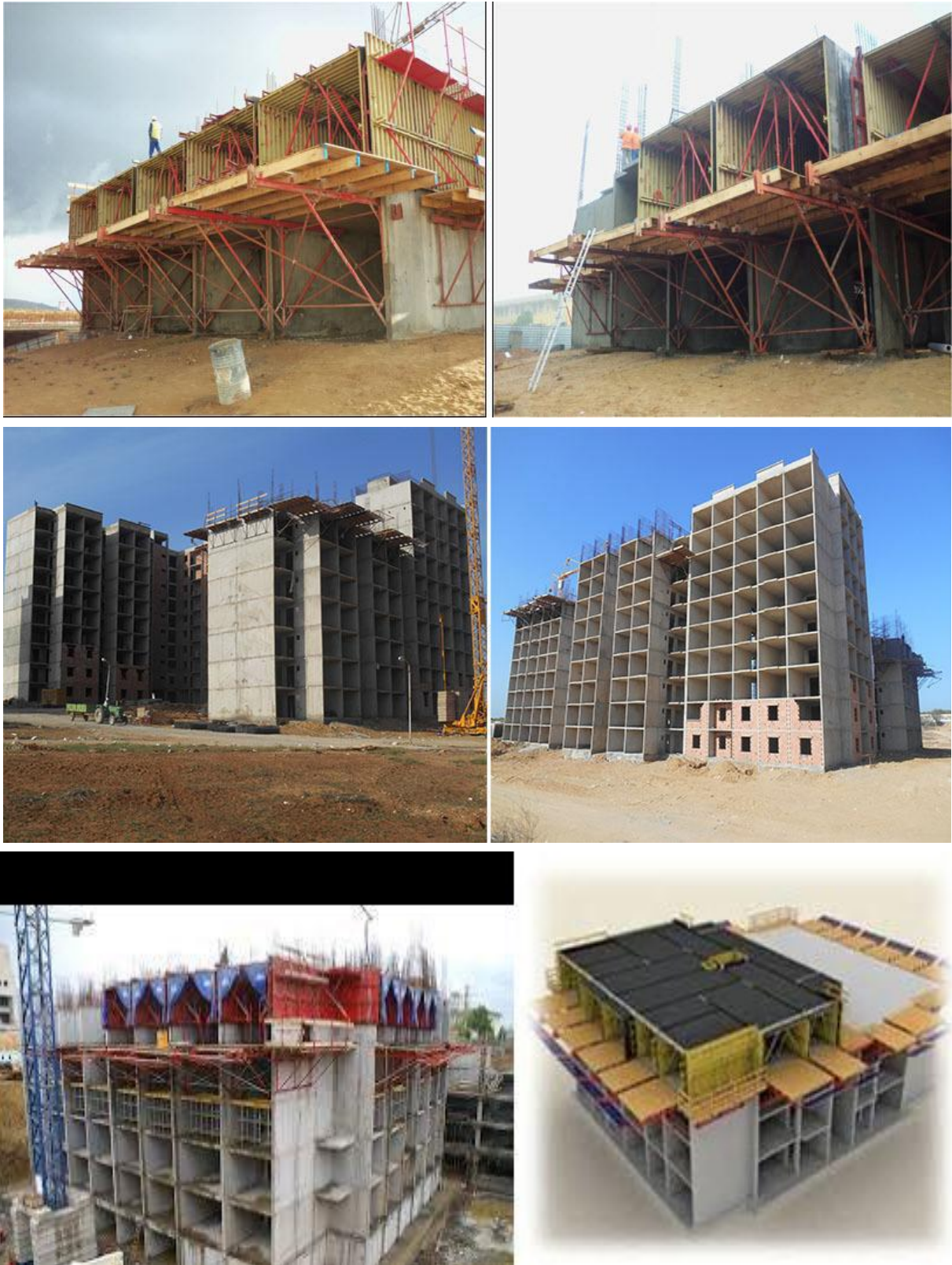
Figure1-12 : Aperçu réel du coffrage tunnel sur chantier
