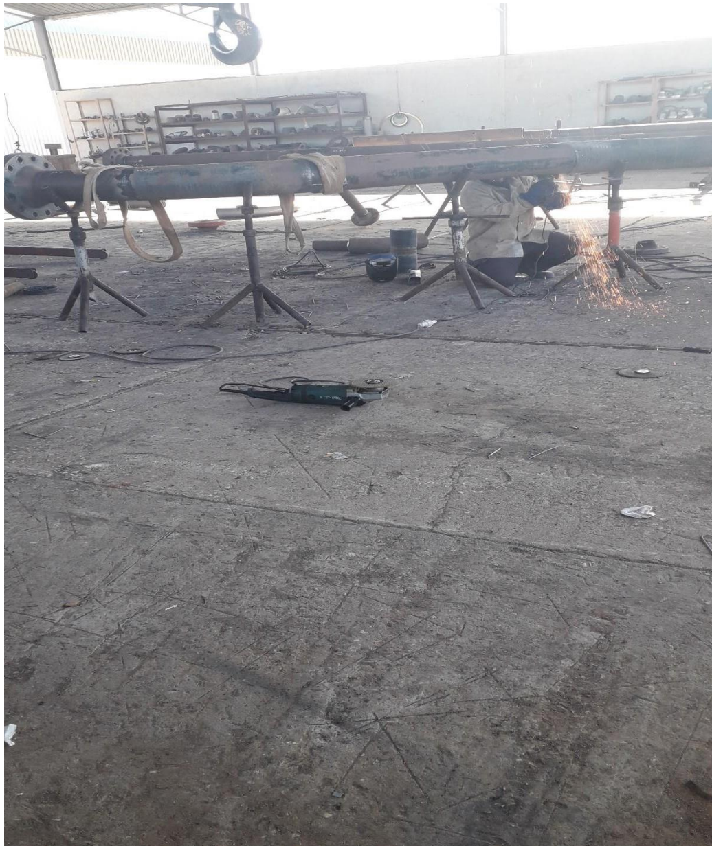
Figure IV, 11 : Soudage en chantier
