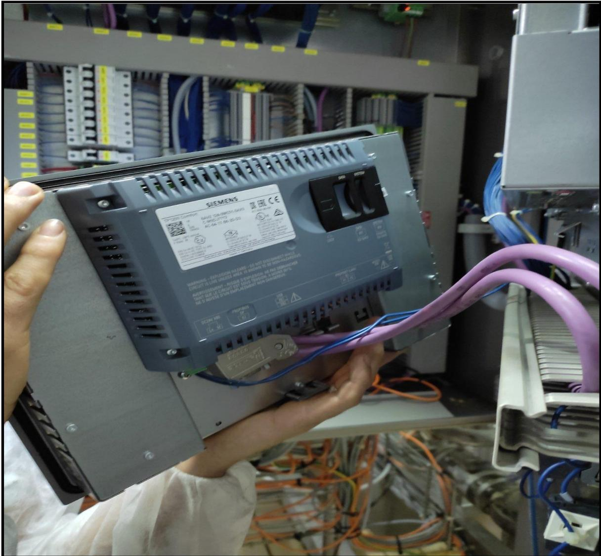
**Figure V. 39** : Communication HMI avec automate UHT s7 300 (Partie1)
