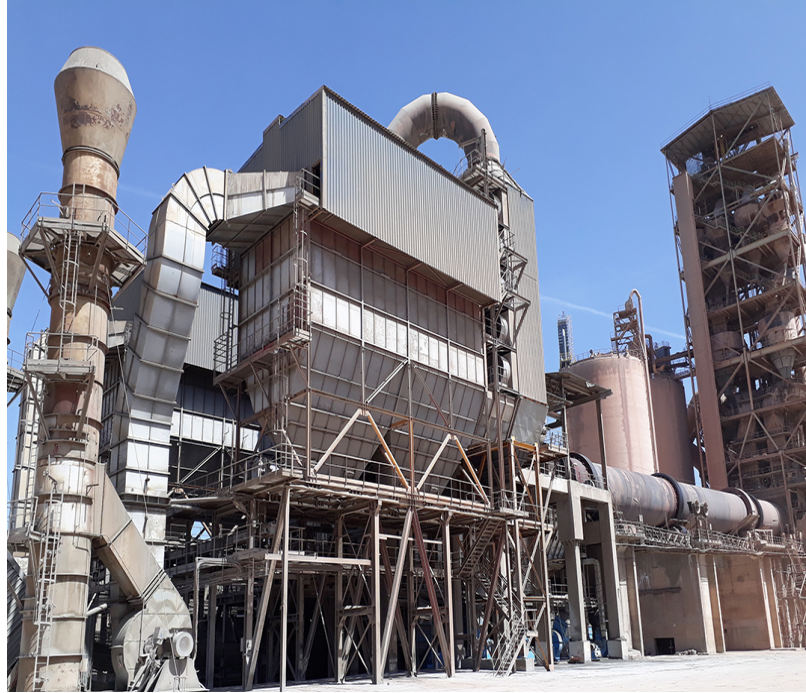
Fig. 5.1 Ain El Kebira Cement plant
