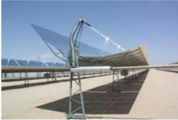
**Figure II.5 :** centrale thermodynamique cylindro-parabolique
